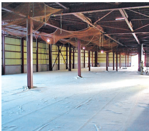
夏場はコンジョーマットの上から散水して下さい。
