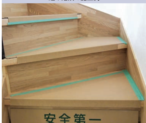
廻り階段の施工例
