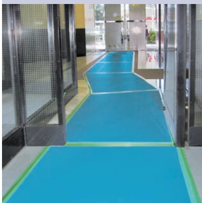
搬入搬出作業時に
