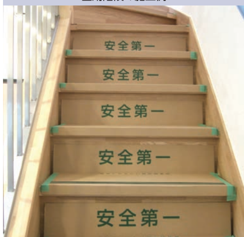
直用階段の施工例
